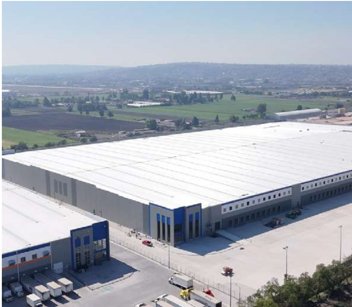
Parque Industrial Danhos Palomas (Nave II) La segunda nave de Danhos Industrial Palomas. Proyecto Build to Suit de 110,000 m² que se desarrollará en tres fases; la primera, de 65,000 m², está en construcción y será entregada en diciembre de 2026.
