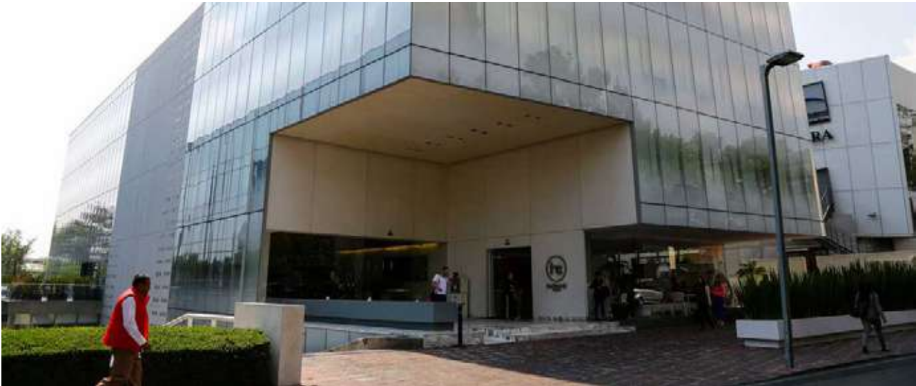
Urbitec Seis niveles de oficinas con núcleos de servicios por planta, integran este moderno edificio ubicado en Bosques de las Lomas. 12,879 m² de área rentable 316 cajones de estacionamiento
