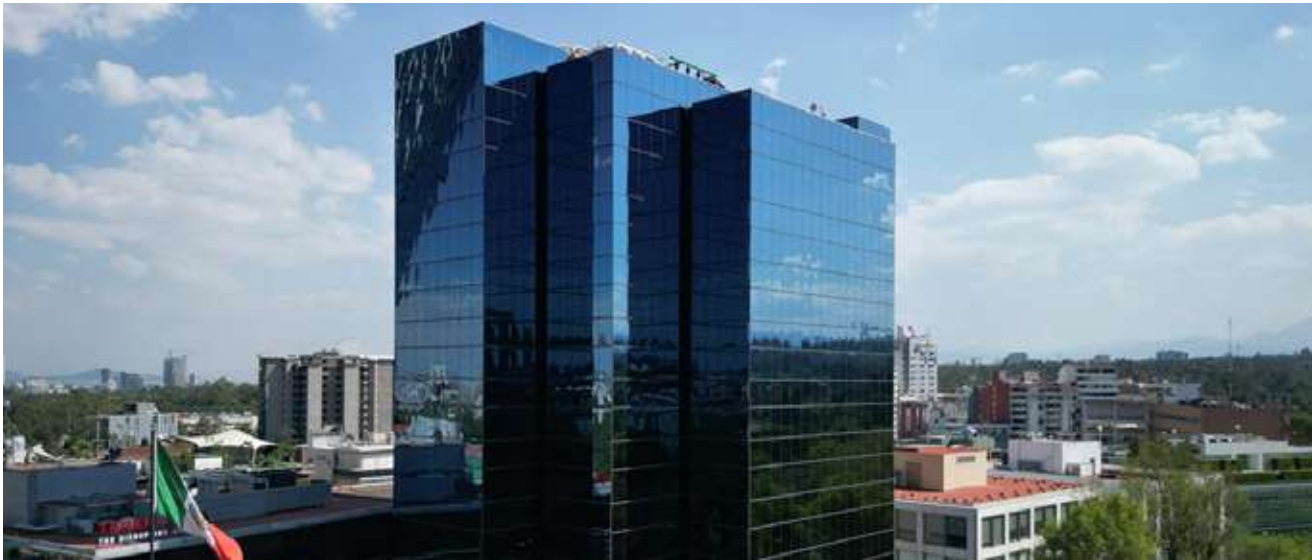
Parque Virreyes A más de 30 años de su construcción, continúa siendo uno de los edificios más emblemáticos en las Lomas de Chapultepec. 7,783 m² de área rentable 251 cajones de estacionamiento
