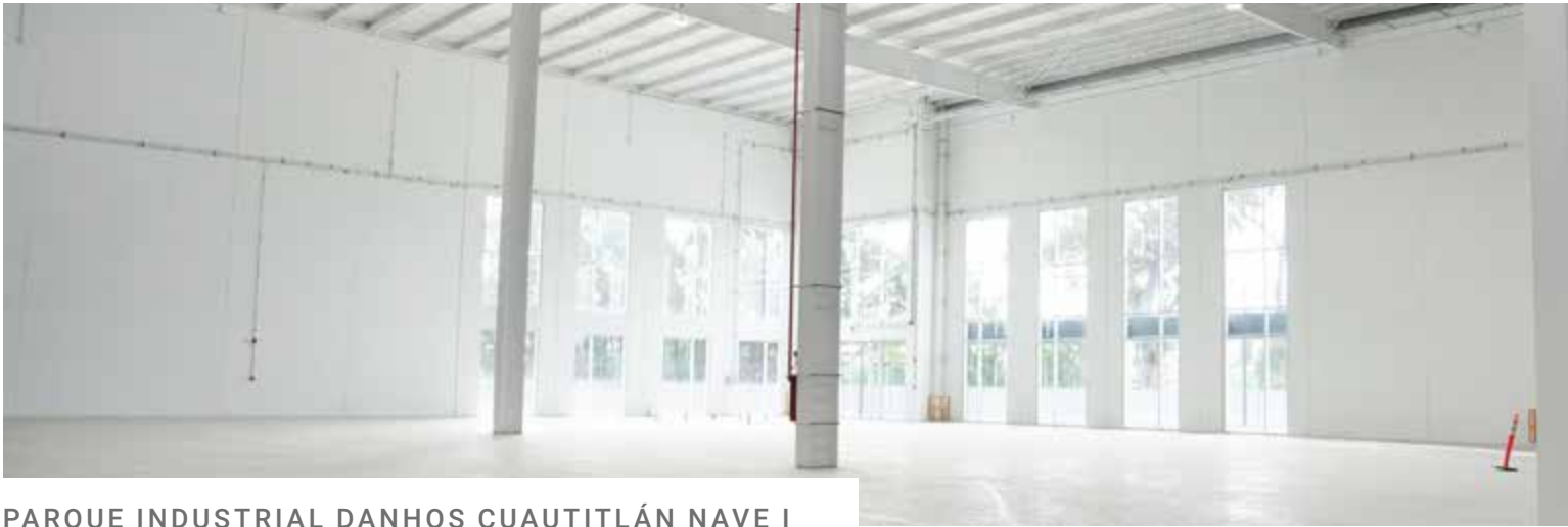
PARQUE INDUSTRIAL DANHOS CUAUTITLÁN NAVE I
